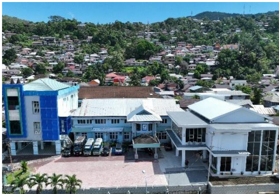
Gambar 20. Gedung Balai POM di Ambon
