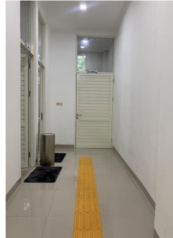
Guiding Block menuju toilet
